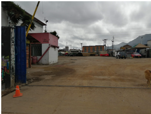
Foto No. 1. Fachada del predio.
